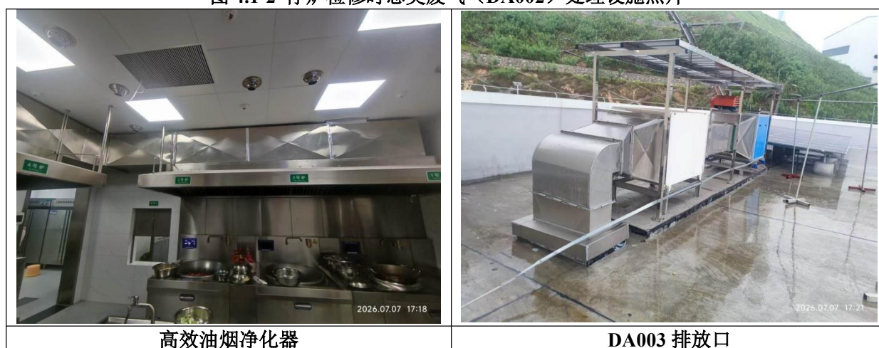
图 4.1-3 油烟废气（DA003）处理设施照片
