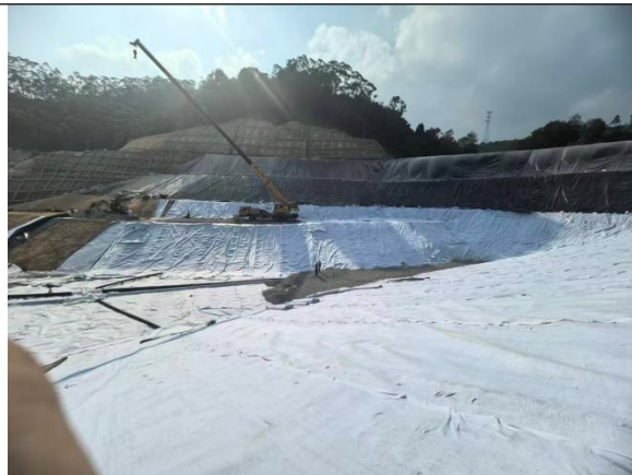
飞灰固化物填埋场覆膜
