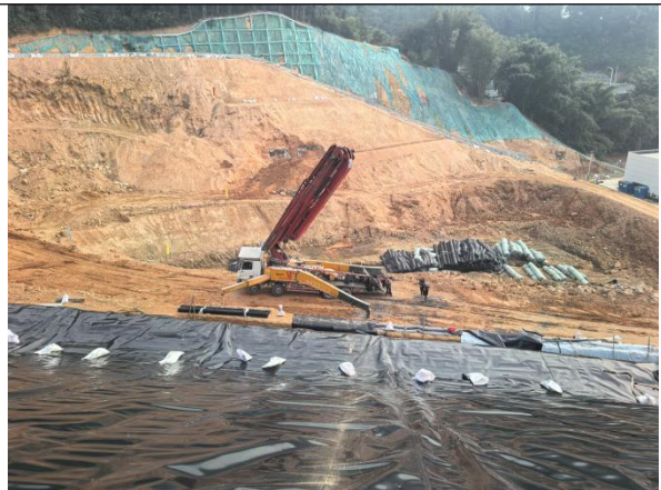
飞灰固化物填埋场覆膜
